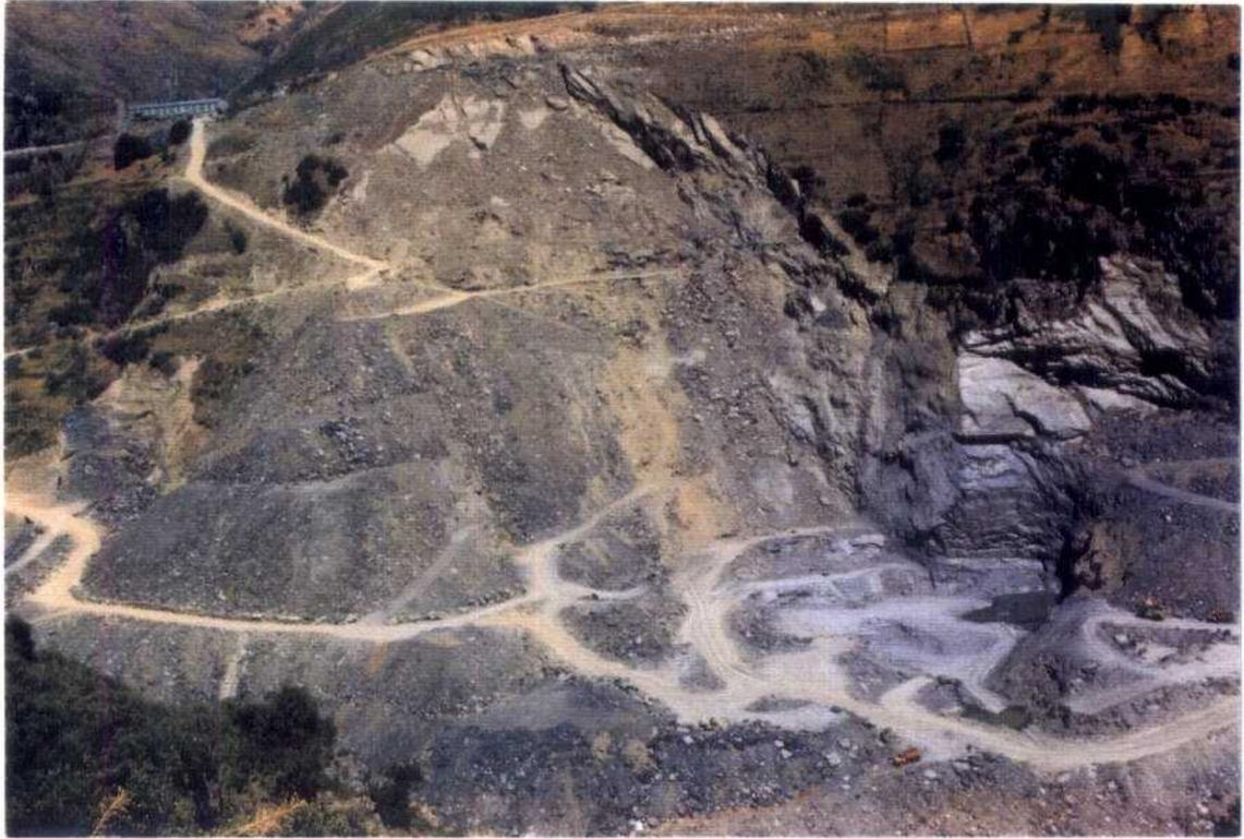
**Fotografía N° 23.- Aspecto general de un talud de muro inestable por deslizamiento plano**
