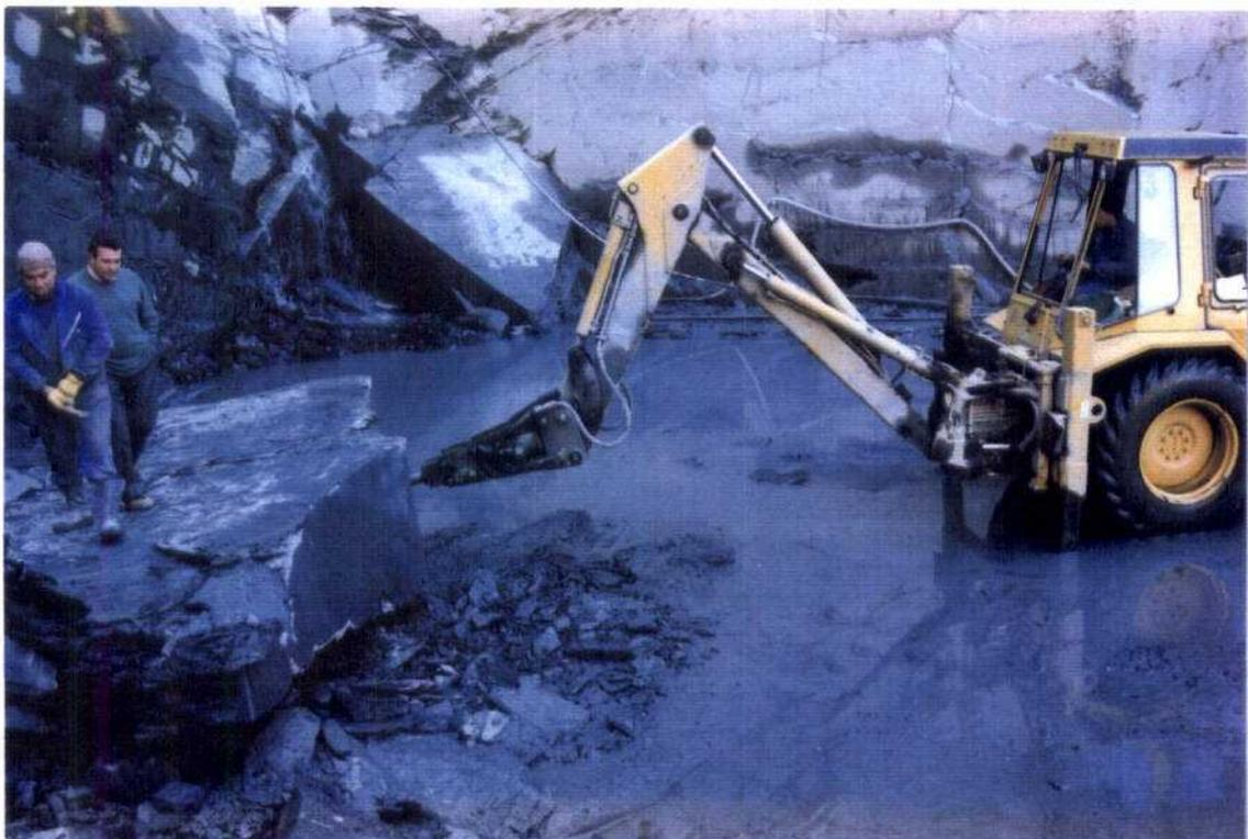
**Fotografía N° 8.- Adecuación del tamaño del ración para su carga posterior**
