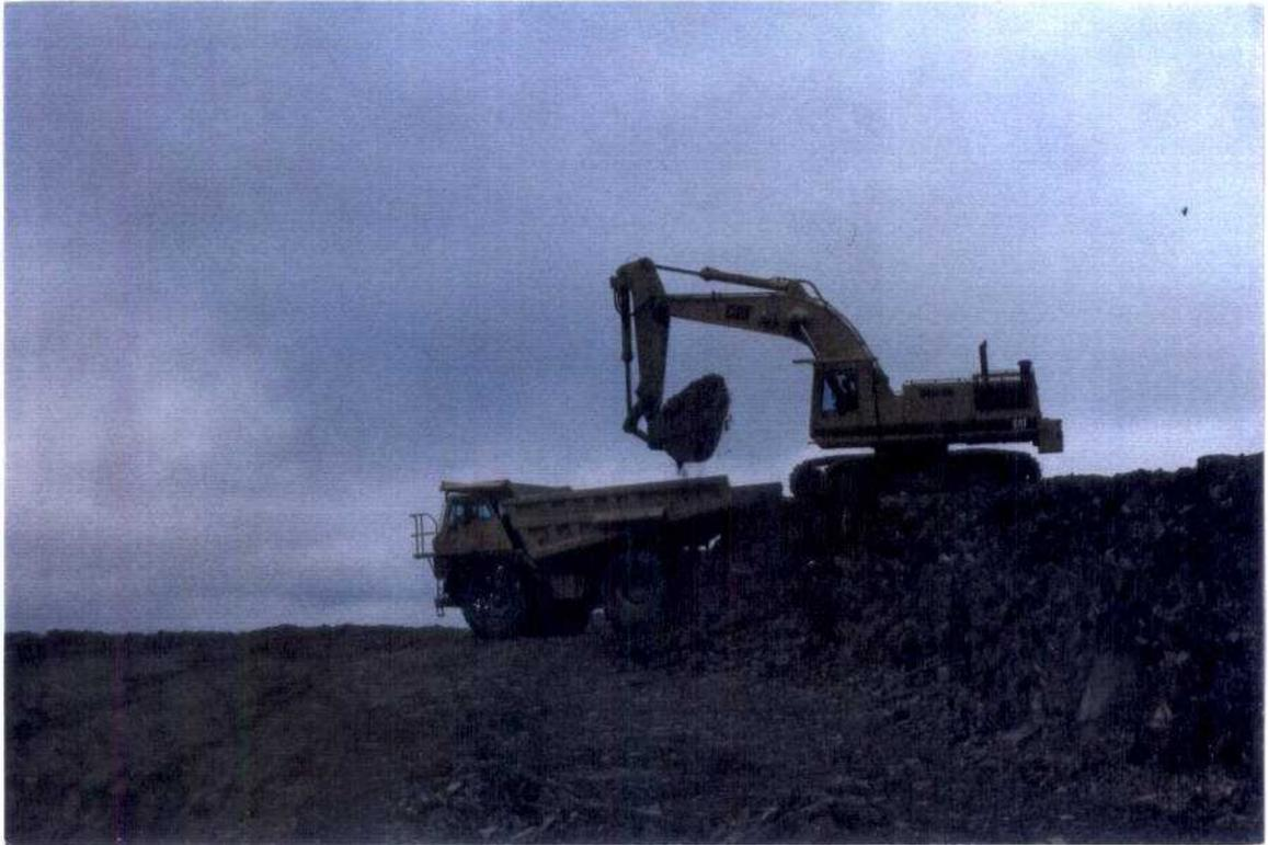
**Fotografía N° 1.- Excavación y retirada del recubrimiento, como paso previo para la apertura de la cantera**
